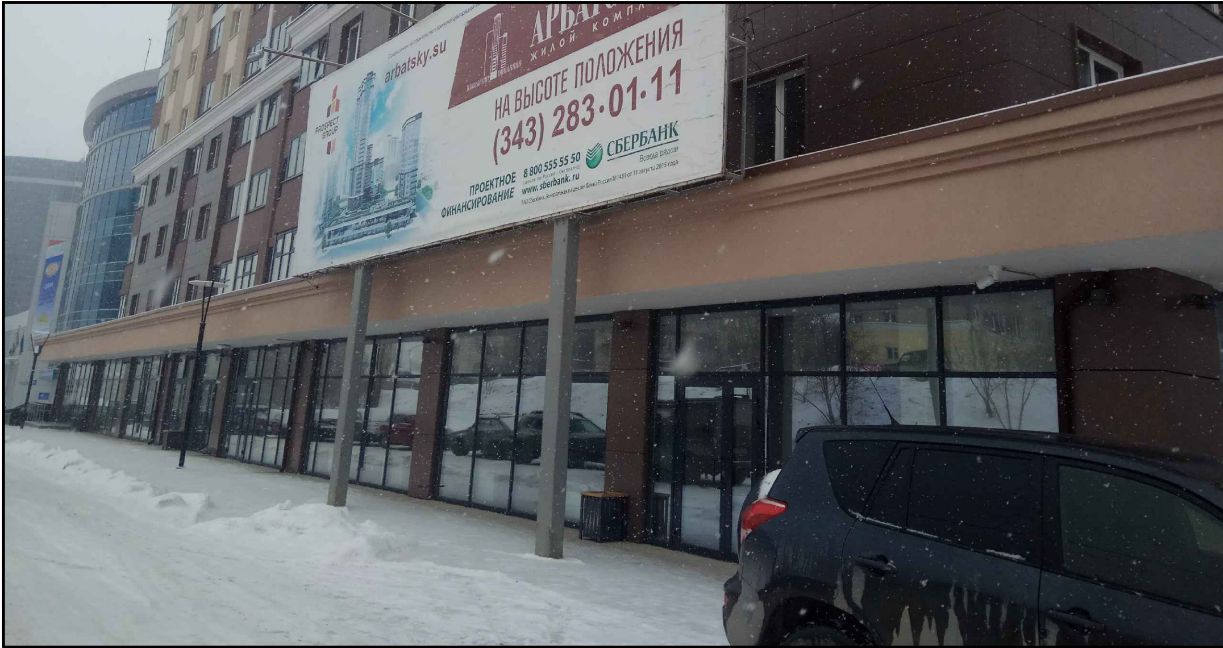
Вид № 3в уровне первого этажа
